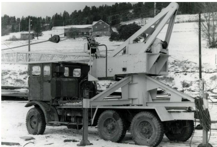
Dette er verftets første (og selvkomponerte) kran. Selve krana er fortsatt i bruk.
